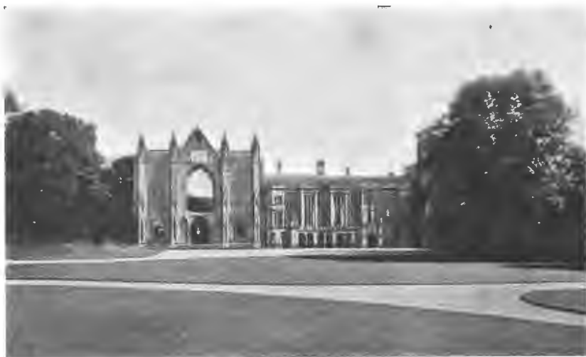
Аббатство. Главный фасадъ.
